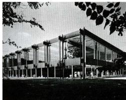
Bâtiment principal vitré abritant un bassin de 25 mètres et un petit bassin jouxté d'une maison de gardien. L'ossature métallique de la piscine est apparente, les doubles poteaux tubulaires rythment les plus longues façades et la poutre-portique transversale en caisson nervuré par profilés en I reconstitués. Une mezzanine suspendue par tirants métalliques divise partiellement le volume de la piscine.
