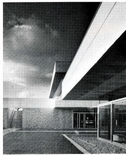
L'architecture volontairement horizontale de cette école est marquée par de grands bandeaux blancs exprimant les terrasses ou les planchers en caissons de béton armé laissé apparent. L'équipement de l'intérieur est entièrement préfabriqué.
