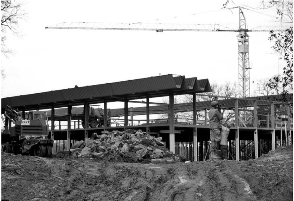
*Mise en place de l'ossature et de la toiture du bâtiment Administration*
