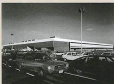
Corbeil-Essonnes (91). Usines IBM 1 et 2, 40 000 m<sup>2</sup>, 1970-1974. Le site en bordure de l'autoroute A6 a conduit à décliner de grandes façades horizontales qui illustrent ce qui se passe à l'intérieur. Dans la même logique, on voit utilisées plusieurs types de bardages métalliques, du bac standard au panneau embouti en pointe de diamant.
