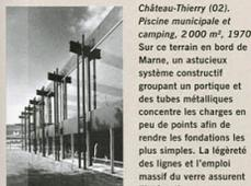
Château-Thierry (02). Piscine municipale et camping, 2 000 m<sup>2</sup>, 1970. Sur ce terrain en bord de Marne, un astucieux système constructif groupant un parapluie et des tubes métalliques concentre les charges en peu de points afin de rendre les fondations les plus simples. La légèreté des lignes et l'emploi massif du verre assurent l'intégration au paysage.
