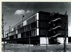
Solaise (69). Centre de recherches ECF, 15 000 m<sup>2</sup>, 1969. La parcelle entre autoroute et canal permet une organisation simple en trois groupes: services généraux, laboratoires de recherches et laboratoires d'application. Les laboratoires de recherches sont entièrement vitrés. Leur orientation nord-sud a conduit à la mise en place de brise-soleil horizontaux et de persiennes verticales en aluminium extrudé.
