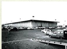
Orly (94). Aérateur de fret mécanique et entrapôt air France, 19 000 m<sup>2</sup>, 1968. Hangar de grande dimension construit à partir d'une structure métallique en parapluie. La clôture du bâtiment est assurée par un « bardage » en béton tridimensionnel autoporteur mais sans fonction structurelle. Un bandeau vitré en partie haute assure l'éclairage et allège la perception de la toiture.
