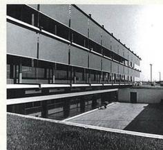
Rungis (94). Gare routière Segaris. 6 000 m<sup>2</sup>, 1966. Le programme nécessitait la construction de plusieurs entrepôts aux usages multiples ainsi qu'un bâtiment d'administration. L'ossature métallique tubulaire, le mur rideau ainsi que les brise-soleil horizontaux en aluminium seront des constantes des réalisations à venir de Vaudou et Luthi.
