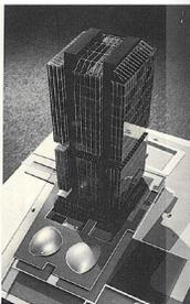
*Projet pour une maison de l'ORTF (Concours 1974). 30 niveaux, structure métallique suspendue et rigulée sur deux piles en béton armé. Possibilité de créer des niveaux intérieurs de volumes différents et d'intégrer les « ensembles » suspendus pour trouver des vides servant de prise d'air pour les centrales, de salles de repas réservoirs, ou d'espaces transparents.*
