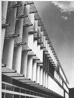
Centre de Recherche des pétroles ELF à Solaim, Laboratoires. Les brins soleil horizontaux fixes sont caractérisés par des profils d'aluminium fives constitués sur l'ossature métallique. Les brins soleil verticaux mobiles sont constitués par des panneaux d'aluminium anodisés de 1,00 x 3,00 m, asservis à des commandes par groupe de 7.
