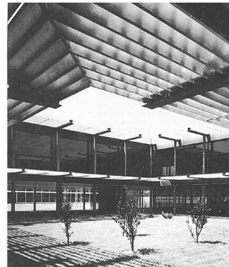
Centre de Recherche des pétroles ELF à Solaim - patio du bâtiment Administration. L'ossature métallique tubulaire enduite est appareillée avec des brins soleil horizontaux fixes. Faciades en glaces fixes et bandeaux d'aluminium laqué.
